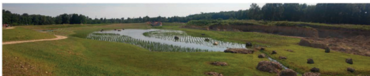
Figura 2 – Area di laminazione vasca 1, zona ecosistema filtro/fitodepurazione. L'immagine mostra anche la scelta di organizzare l'avanzamento dei lavori in modo da completare progressivamente la sistemazione naturalistica e paesaggistica delle opere.
