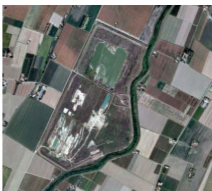
Figura3 – Lavori in corso; 2008.
