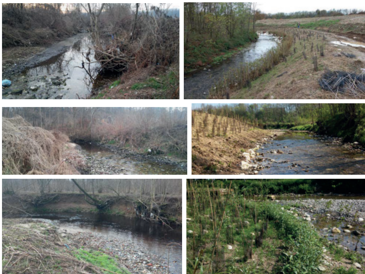
Figura 3 – Alcune immagini rappresentative dello stato del torrente Lura nel tratto in argomento, prima dell'inizio degli interventi di progetto (sulla sinistra), a confronto con le sistemazioni realizzate (a destra). Dall'alto: il tratto di valle (lanca Sud) appena prima della futura immissione dello scarico dalle aree di laminazione; la zona di Lura a valle di lanca Nord; l'ansa in corrispondenza di lanca sud.
