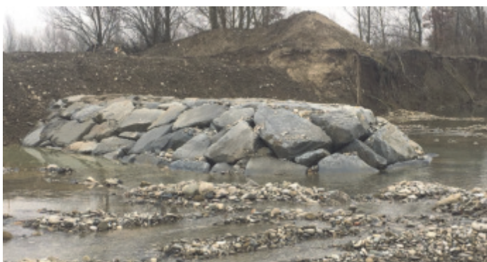
Figura 4- Vista del pennello durante la fase conclusiva delle lavorazioni (feb 2018)
