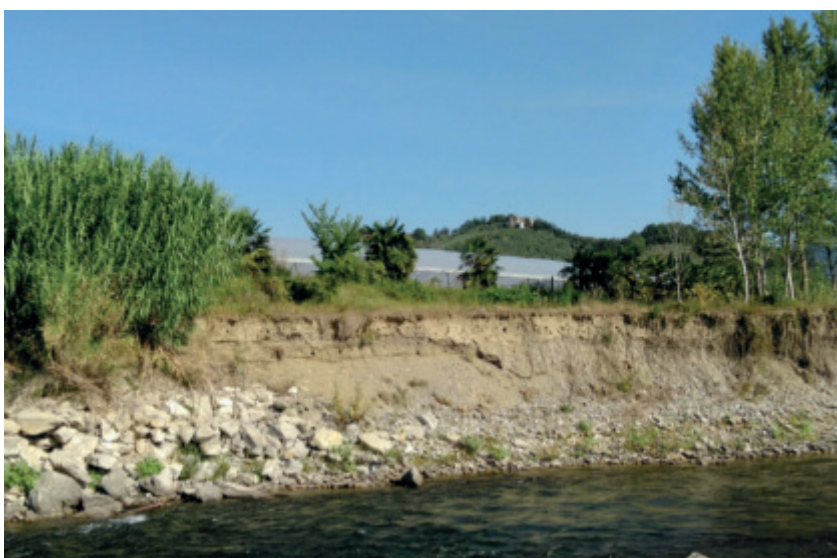
Figura3 – Sponda destra in erosione prima dell'intervento di consolidamento
