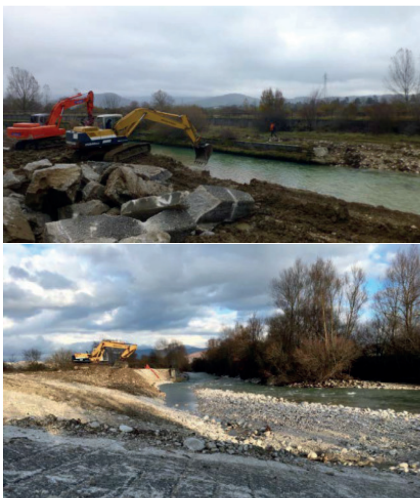
Figura 3 – Rimozione delle difese spondali interne e ampliamento dell'alveo attivo.
