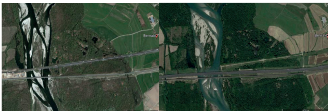
Figura 1 – Ortofoto (Google Earth) del tratto di Ticino interessato dalla realizzazione delle opere infrastrutturali. La situazione nel 2012 (a sinistra) con la nuova ferrovia AC e l'esistente A4 Mi-To e nel 2017 (a destra) con le due nuove infrastrutture in allineamento e il recupero del vecchio sedime autostradale.
