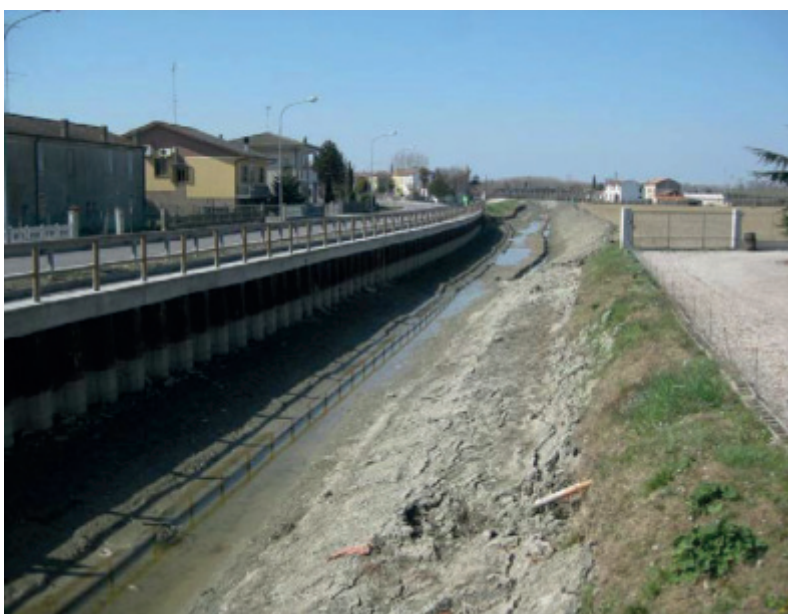
Figura 2. Tratto della Fossa Lavezzola durante gli interventi di riqualificazione.
