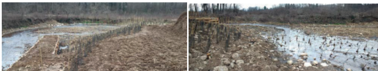
Figura 5 – Intervento di riqualificazione fluviale della lanca nord: arretramento di circa 30 metri della sponda destra; realizzazione di pennello in legname e pietrale per protezione della sponda e indirizzamento della corrente verso il tracciato originario; piantumazione di ontani neri al piede della sponda; piantumazione delle sponde; formazione di piccoli nuclei di scogliere nei punti di impatto diretto delle correnti; formazione di soglie a raso con massi per migliorare la distribuzione della corrente lungo la sezione; protezione del tratto di valle con copertura diffusa con astoni di salice.
