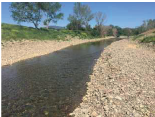
Figura 2 – Stato attuale fiume Cornia. Intervento 1: loc. Campo alla Gera/Vivaldina
