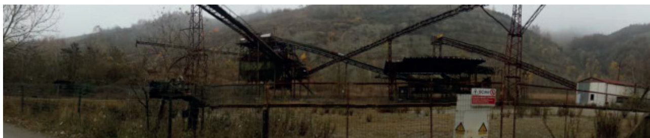
Figura4 –Vista impianto dismesso che sovrasta il tratto tombinato del Rio Rocca.
