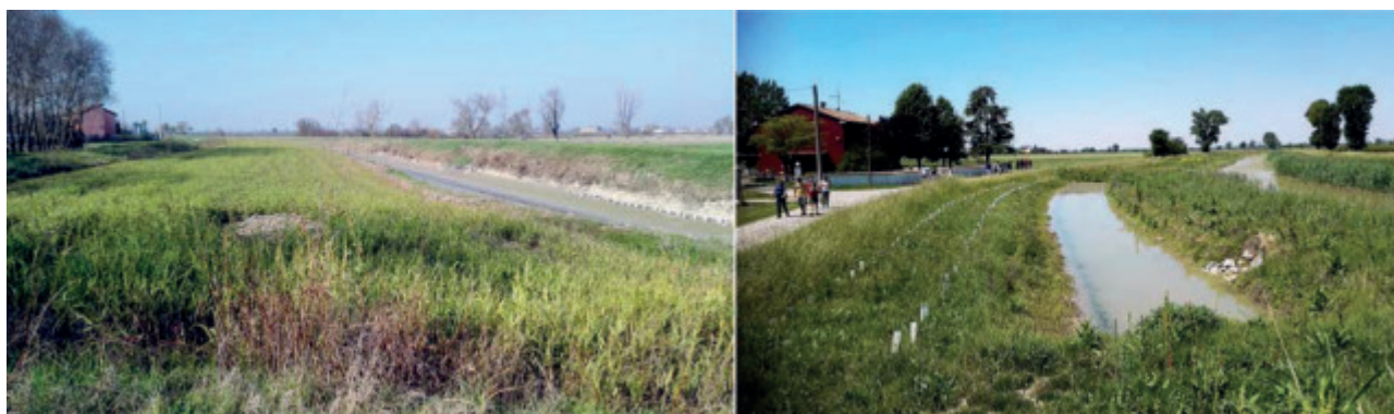
Figura2 – L'intervento realizzato lungo il Collettore Alfieri: confronto tra la situazione iniziale (a sinistra) e a lavori completati (a destra).
